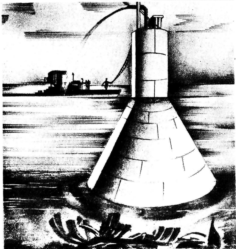
LA TORRE DEL DR. BECKER. Para sacar de la arena "La Lutine" los ingenieros habían concebido primero este enorme cilindro, sumergido exactamente sobre los restos, que debía hacer ventosa y aspirar la arena por medio de poderosas bombas. Pero una tempestad desmanteló el aparato durante las pruebas.
