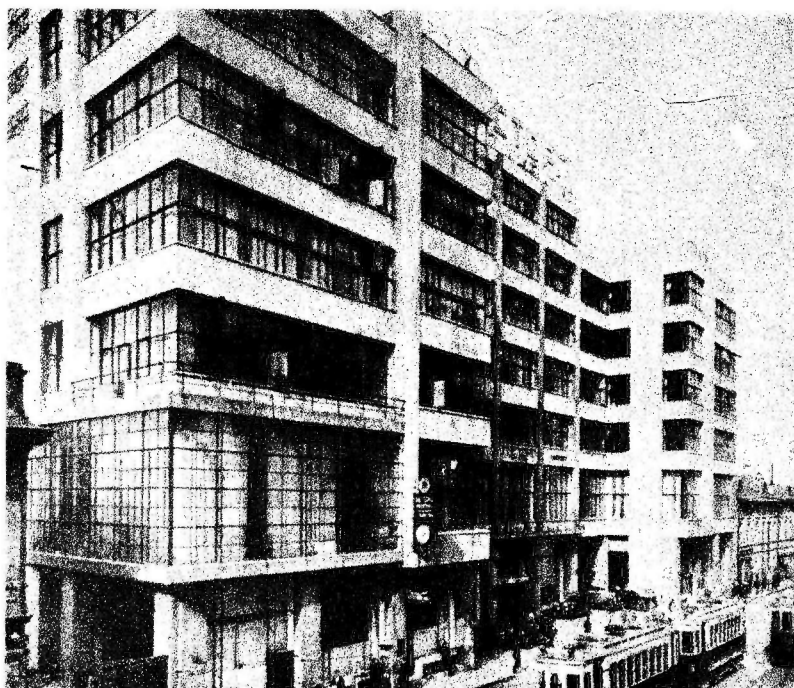
Edificio State Trade
